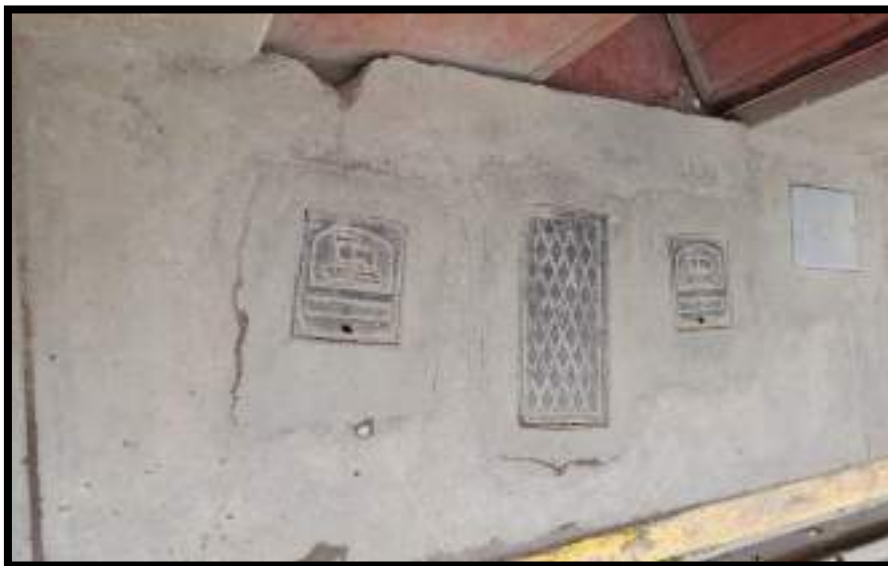
Imagen N° 23: Sistema de desagüe del caserío de Carmen Rosa
