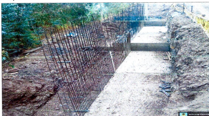
FOTO N°06. Acero expuesto en muro de contención M-09 Huaripampa medio.
