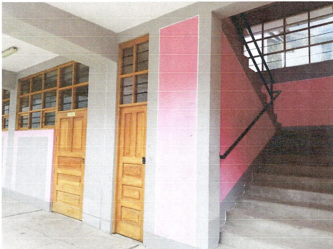
FOTO N° 01: Se observa ambientes construidos con el PI "MEJORAMIENTO DE LOS SERVICIOS EDUCATIVOS DE LA INSTITUCIÓN EDUCATIVA N° 86384 DEL CENTRO POBLADO DE PICHU QUINHUARAGA, DISTRITO DE SAN MARCOS-HUARI-ANCASH"
