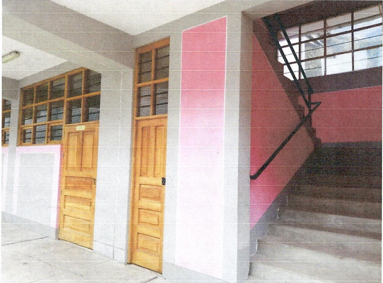
FOTO N° 04: Se observa la escalera que conduce al segundo nivel.
